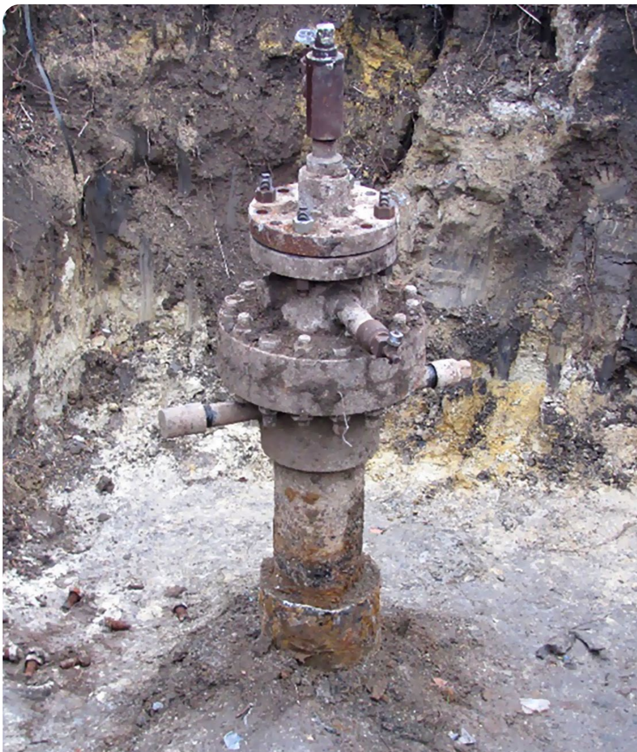
▲ Hrušky 81- obnažení ústí sondy
