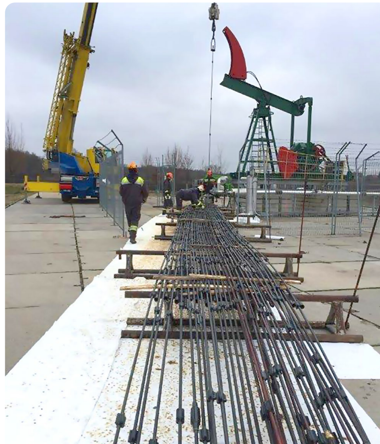
▲ Výměna táhlic na sondě Poštorná
